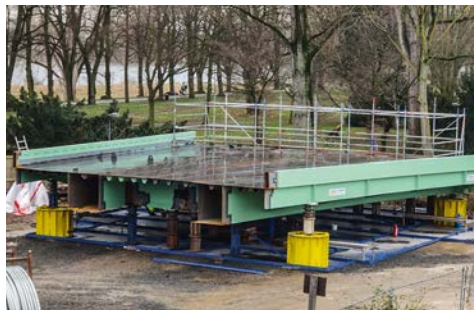
Vormontage eines Stahlbauteils
